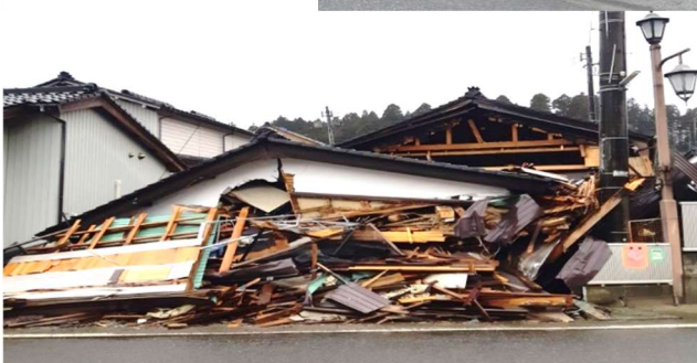
倒壊した家屋
